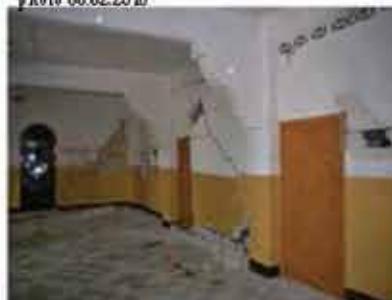
Salle donnant sur l'entrée de l'édifice. Les reprises de maçonneries peuvent conduire à refaire intégralement certains remplissages mais les structures demeurent portuses photo 06.02.2010
