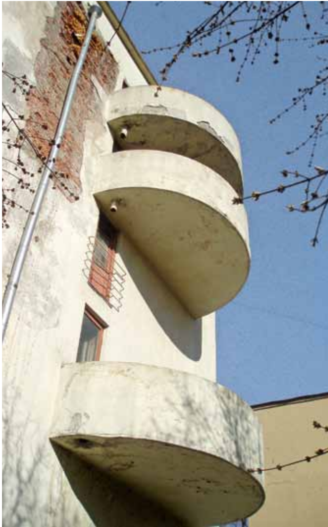
Narkomfin Commune House (photo: A. Zalivako).
