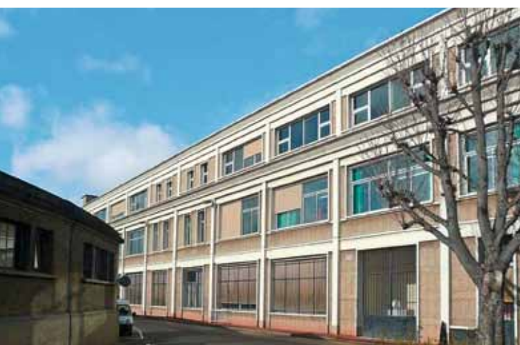
Bâtiment administratif, menacé de destruction (photo: Docomomo)
