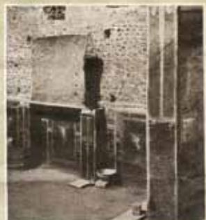
L'interno durante gli scavi di inizio '900
