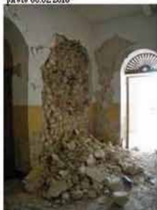
Entrée de l'édifice vers le hall présentant les matériaux constitutifs des murs. Moellons calcétrés ayant présenté une certaine souplesse lors du séisme. photo 06.02.2010
