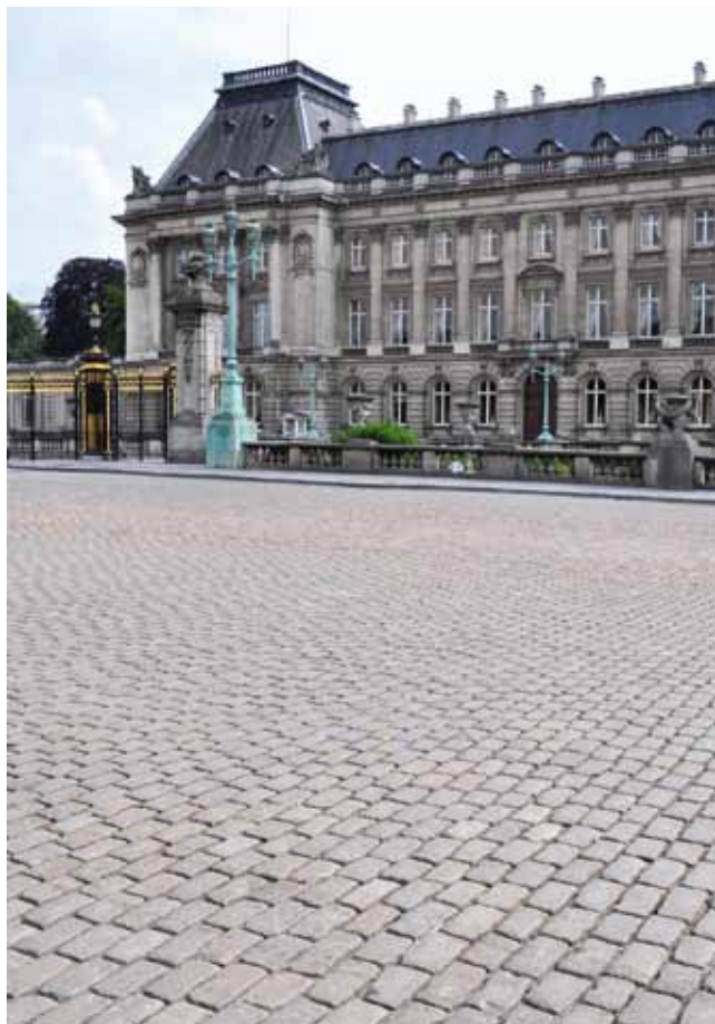
Pavés en granit. Pose traditionnelle jointive en quinconce (place des Palais à Bruxelles – en arrière plan le Palais Royal)
