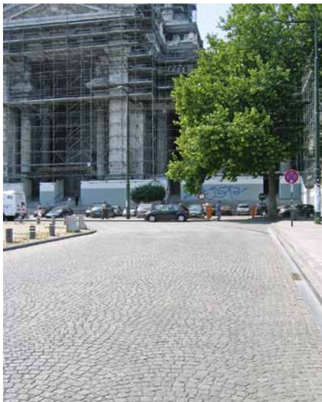
Pavés en grès posés en éventail (place Poelaert à Bruxelles)
