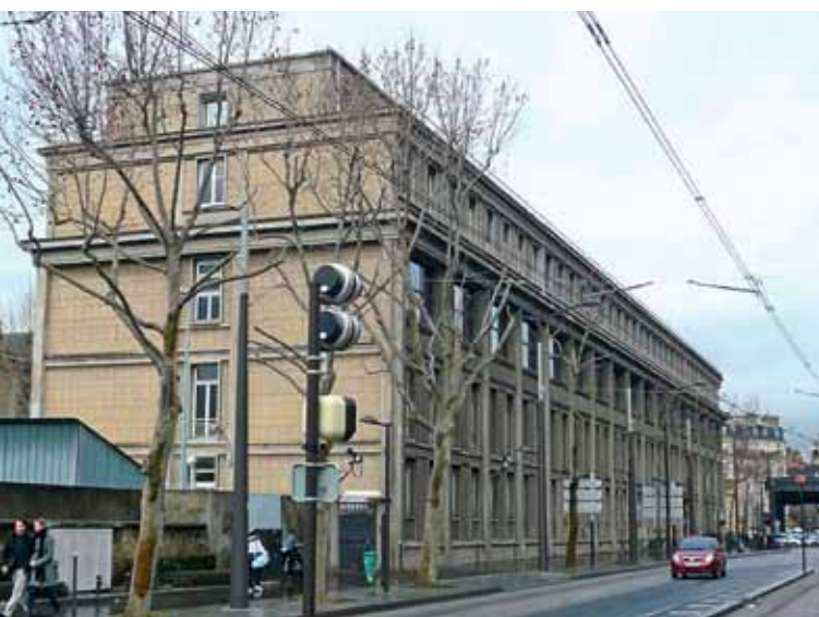
Bâtiment administratif, l'aile sur l'avenue de la Porte de Sèvres (photo: Docomomo)
