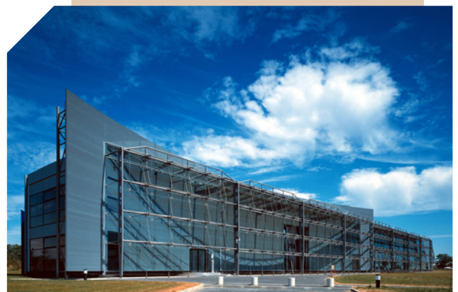
La façade en double vitrage vissé suspendu du bâtiment abritant la BPO
